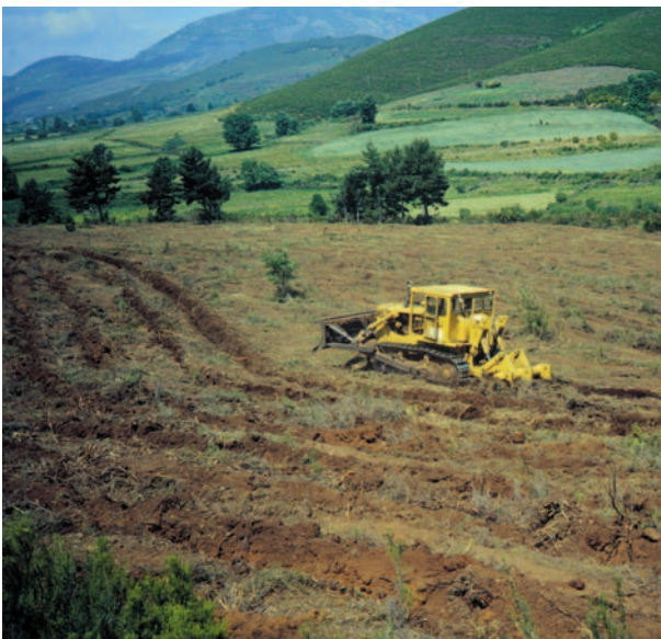
Bulldozer subsolando en curva de nivel en pendiente < 35 %.
